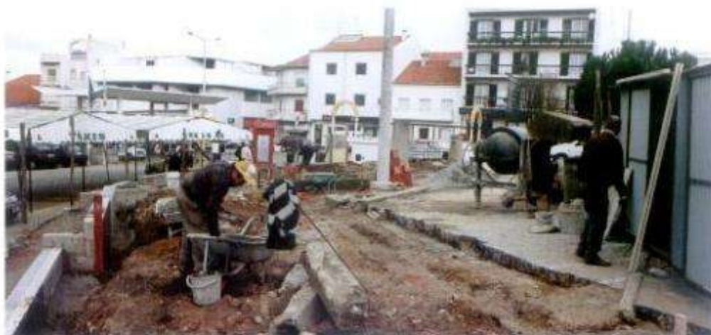
No Largo Colóstea Gulbenkian estão a ser efectuados arranjos exteriores.
