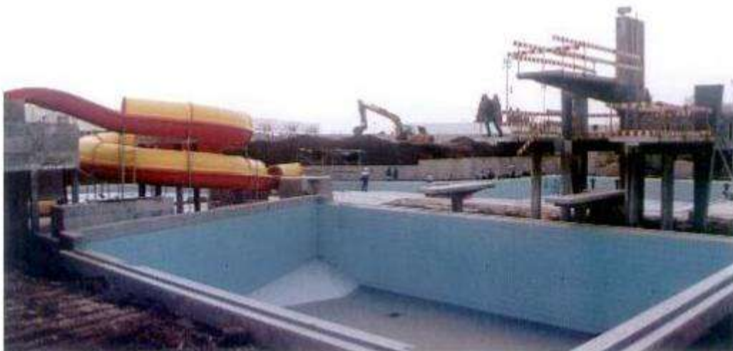
Construção das novas piscinas recreativas de Montemar-o-Novo
