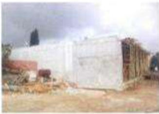
Construção de novas depuradoras de águas em N.º 37 de Visitação
