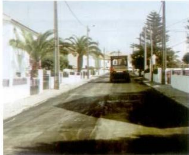
Pavimentação da rua Simão da Veiga - Montemar-o-Novo
