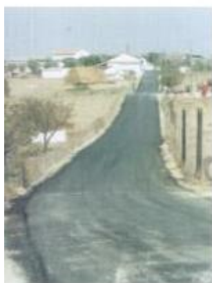
Rua em Boides recentemente pavimentada
