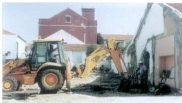
Início da construção do Centro de Convívio para reformados e idosos em Cabele
