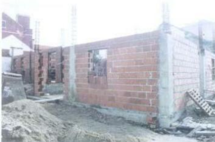
Em Cobreia prosseguem as obras de construção do futuro Centro de Cativeiros de Refletadas
