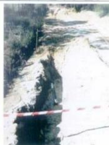
Em Cortiçadas de Lave procedeu-se ao reforço do abastecimento de água nos lugares de Colorões e Alhos Vedros
