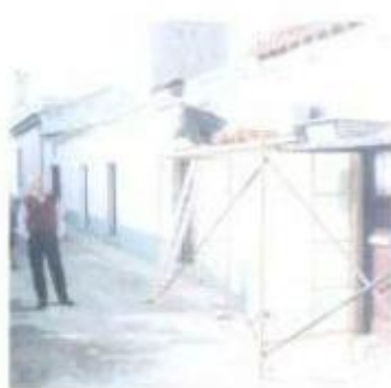
O presidente da Câmara deslocou-se ao local onde estão a ser construídas várias habitações que estão a sofrer obras de recuperação
