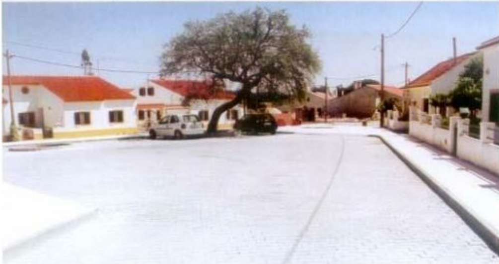
Arranjos exteriores no Bairro da Ajuda, em Cortiçadas de Lavre
