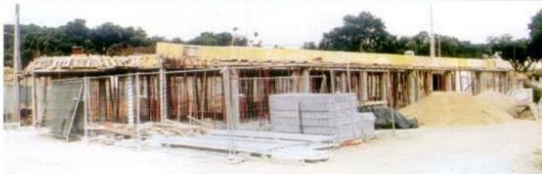
Construção do Canal Municipal, situado na Estação da ADUA
