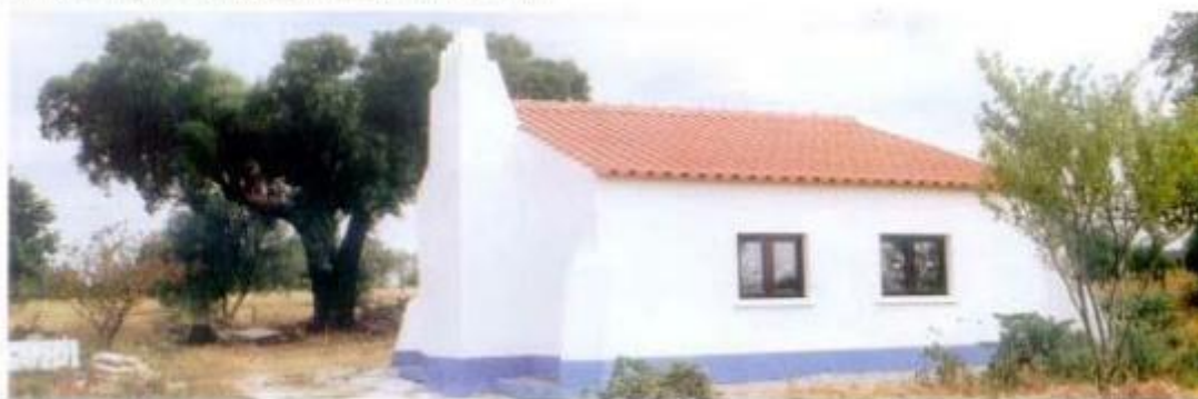
Recuperação de Telhadas nas Casas da ADUA
