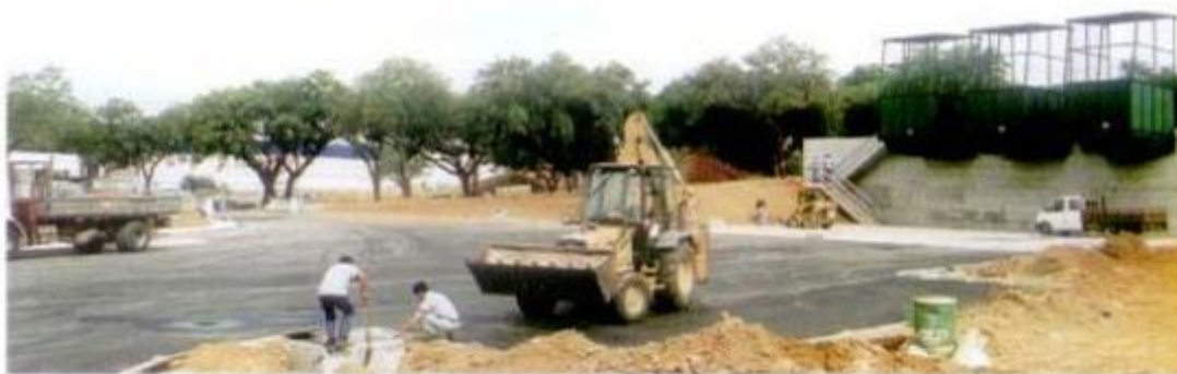
Construção da Estação de Compostagem na Zona Industrial da ADUA
