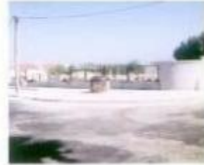
A obra de construção da vedação e estacionamento na Rua Dr. Vicente P. Silva e Rua de N.º Sr.ª da Visitação, perto das Piscinas Municipais, está praticamente concluída.
