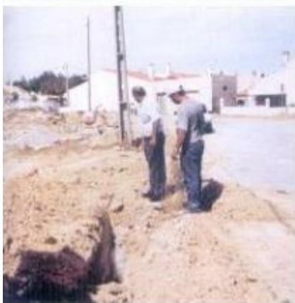
Estão a ser efectuadas obras de beneficiação de regatos, pluviais e passeios no Loteamento de Cortiçadas de Lavre
