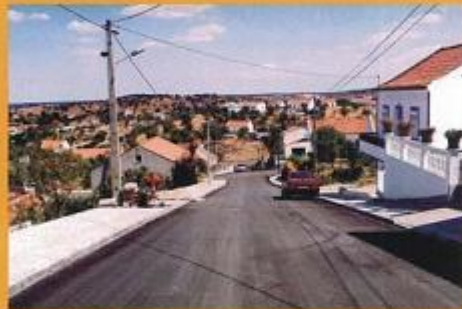
> A melhoria das estradas e vias do nosso concelho tem sido uma preocupação da autarquia que, ao longo dos anos, tem apostado fortemente na sua pavimentação e cobertura.
