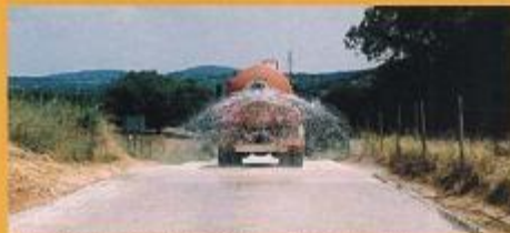
► Início da Pavimentação da Estrada Privada - Nossa Senhora da Vía
