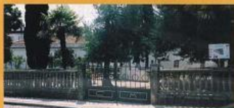
► Já se encontra encerrado o Jardim dos Cavaleiros. Brevemente iniciam-se as obras de remodelação.
