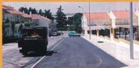
► Pavimentação de parque de estacionamento da Rua Di. Vicente A. Silva
