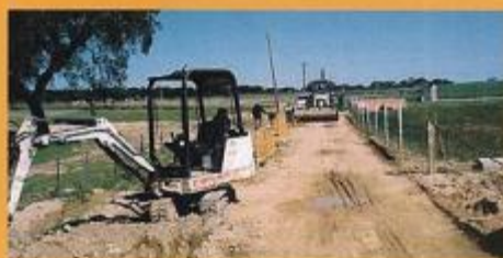
► Obras de saneamento básico no Cortiço
