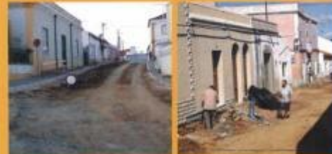
» Obra de colocação de infraestruturas pluviais, Escoural
