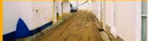
Renovação da rede de abastecimento de água na Rua Cândido dos Reis, Escoura
