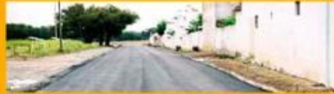
Pavimentação da Rua Almeida, Casa Branca
