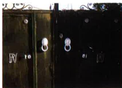
Batentes em forma de ferradura, com suporte de cabeça de cavalo.
