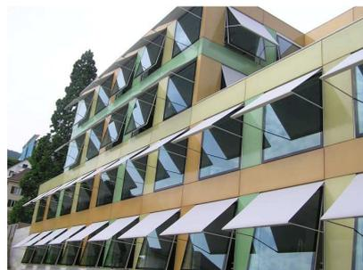
**Figura 21- Exemplos de sombreamento exteriores.**
