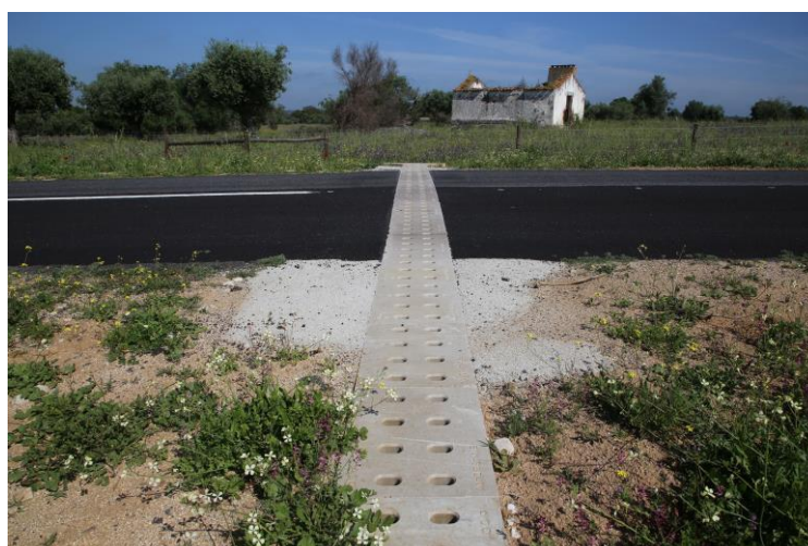
Beneficiação da EM 535- Santiago do Escoural/São Cristóvão
