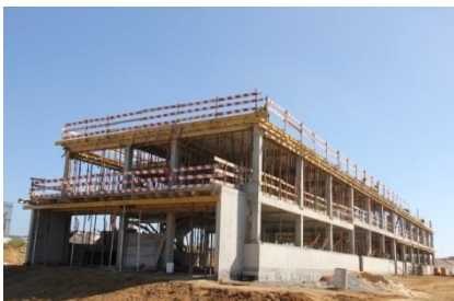
Construção do Centro de Acolhimento à Micro e PME's
