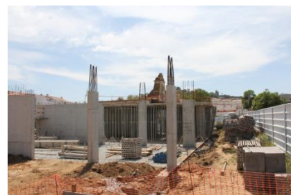
Construção do Centro Escolar
