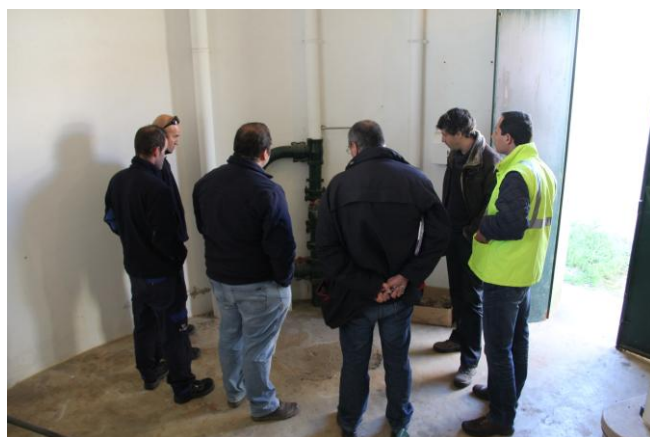
Automatização de água a Cabrela
